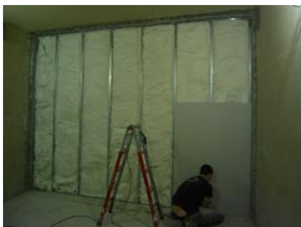
Colocação da Lã de PET SAGON Eco PET 50
