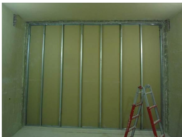
Parede em construção
